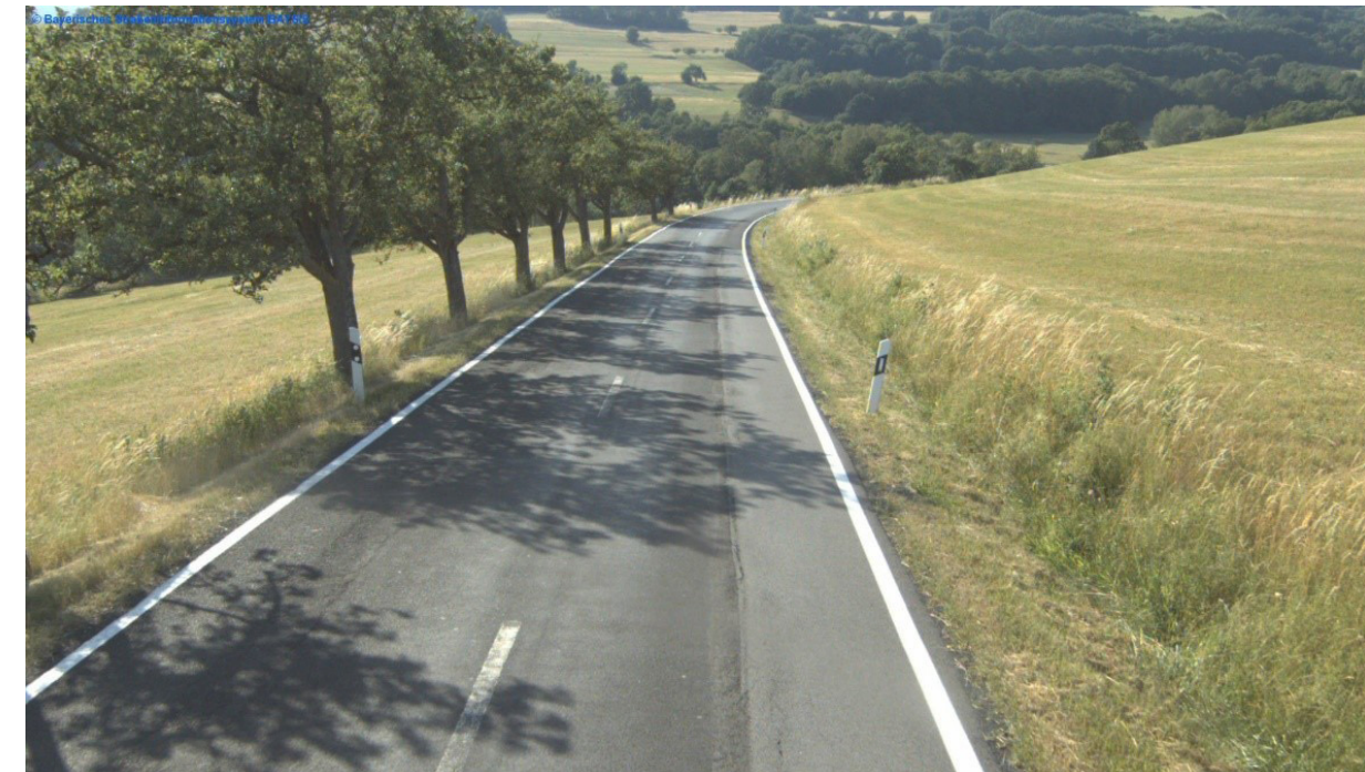
» Abb. 23 Beispiel für eine Landstraße mit regionaler Verbindungsfunktion
