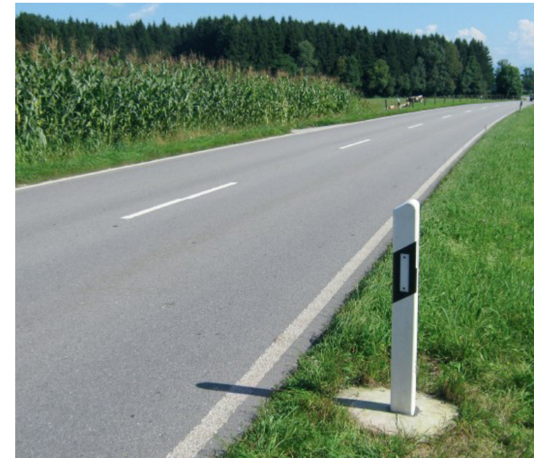
» Abb. 25 Leitpfosten mit Zählgerät (von außen nicht als solches erkennbar)
